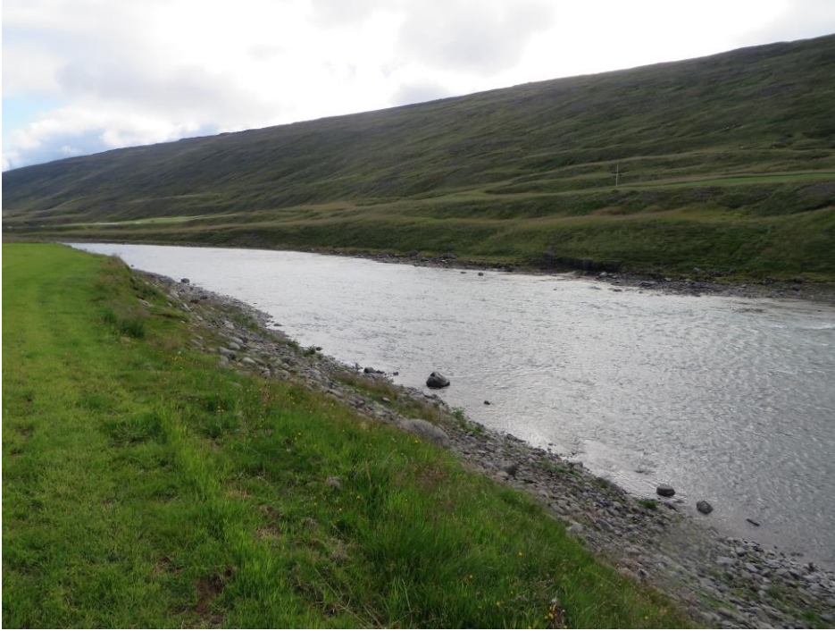
21. mynd. Rafveiðistöð í Jöklu við Skjöldólfsstaði.
